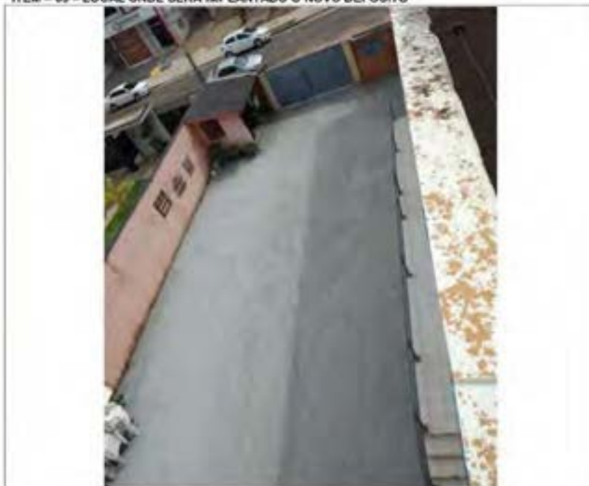
Fig 04. Área onde será construído um novo depósito;
