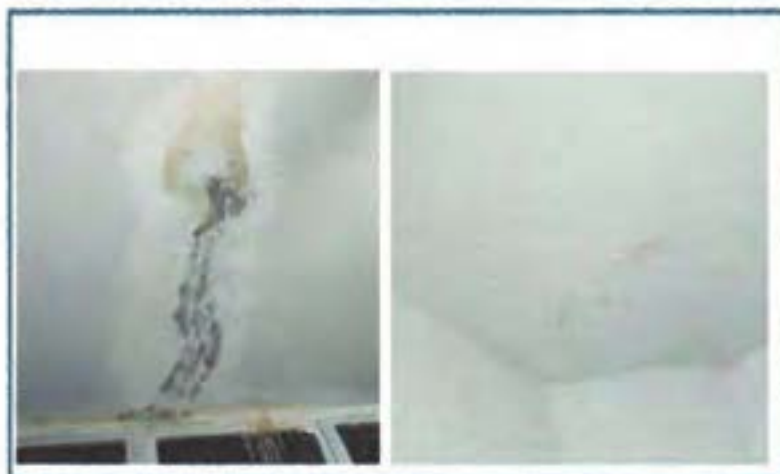
Fig 05. Forro em laje da sala de estética.
