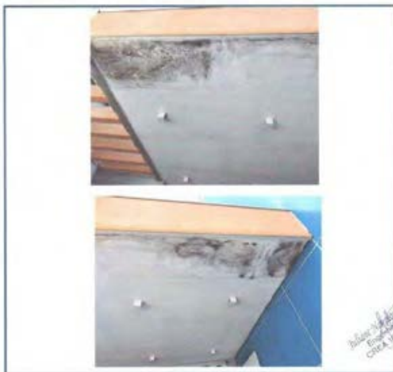
Fig 01. Entrada principal: Forro em gesso a cartonado;
