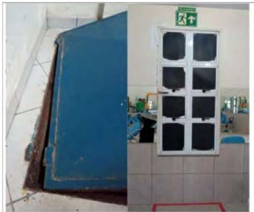
Fig 11. Troca de esquadrias portas do alçapão do reservatório e trocas de portas de saída de emergência e demais portas;
