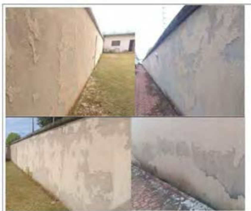
Fig 04. Situação atual dos muros.
