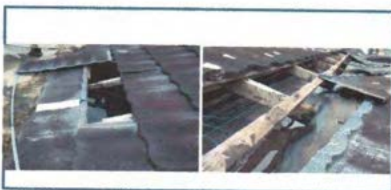
Fig 06. Cobertura da sala de estética;
