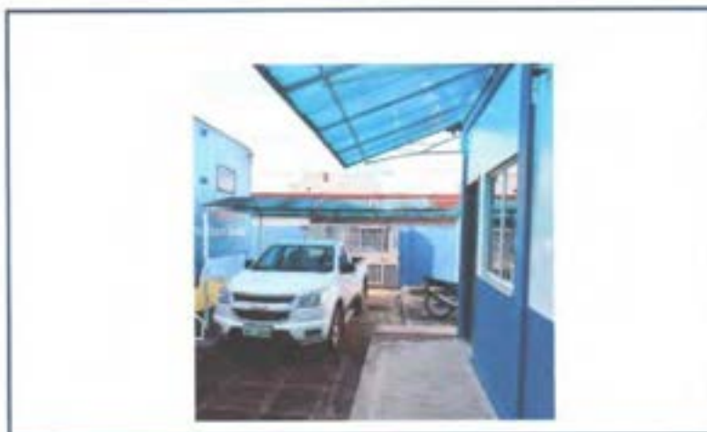
Fig. 02 – Toldo em policarbonato
