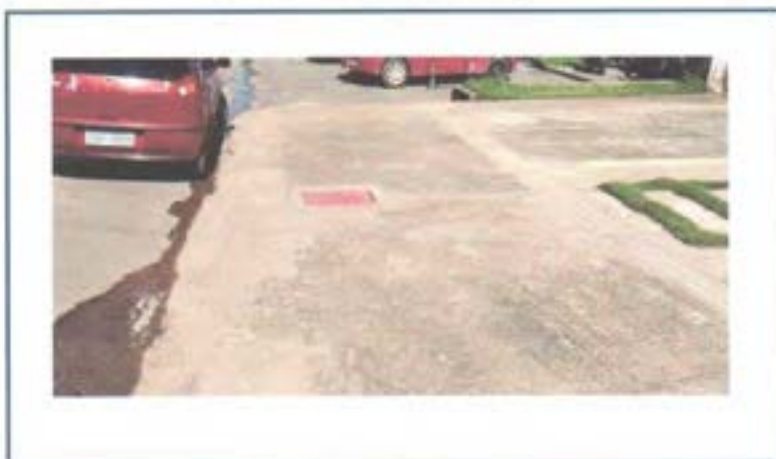
Fig. 03 Adequação de sistema de incêndio.
