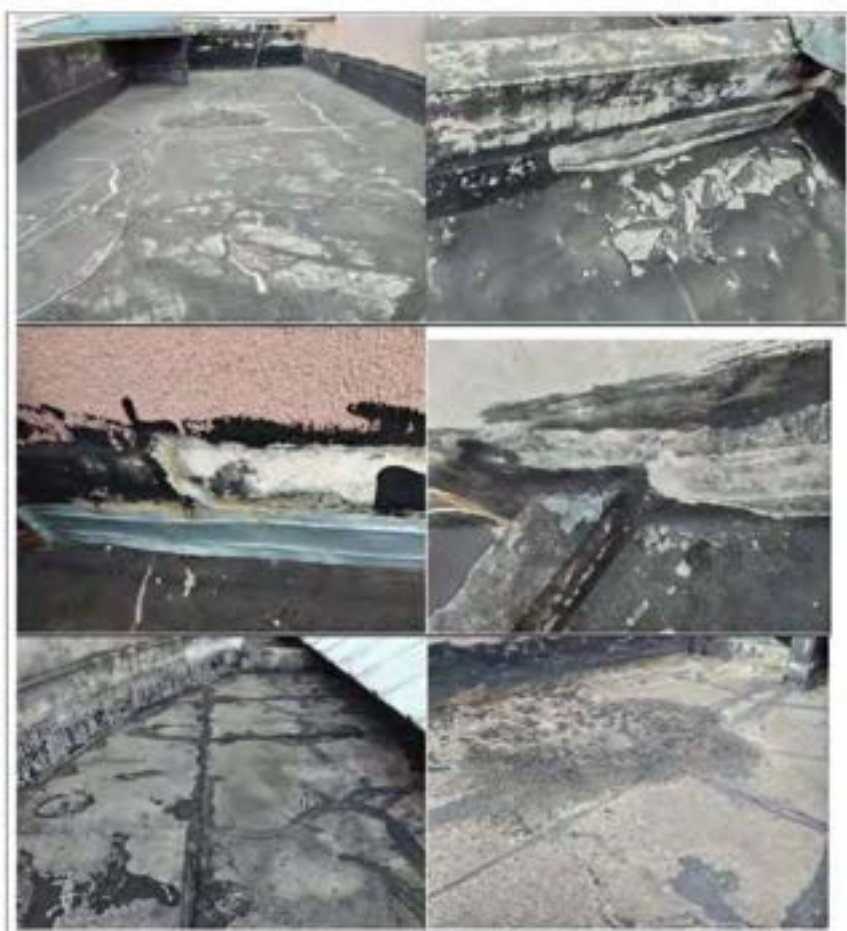
Fig 05. Laje da Edificação;
