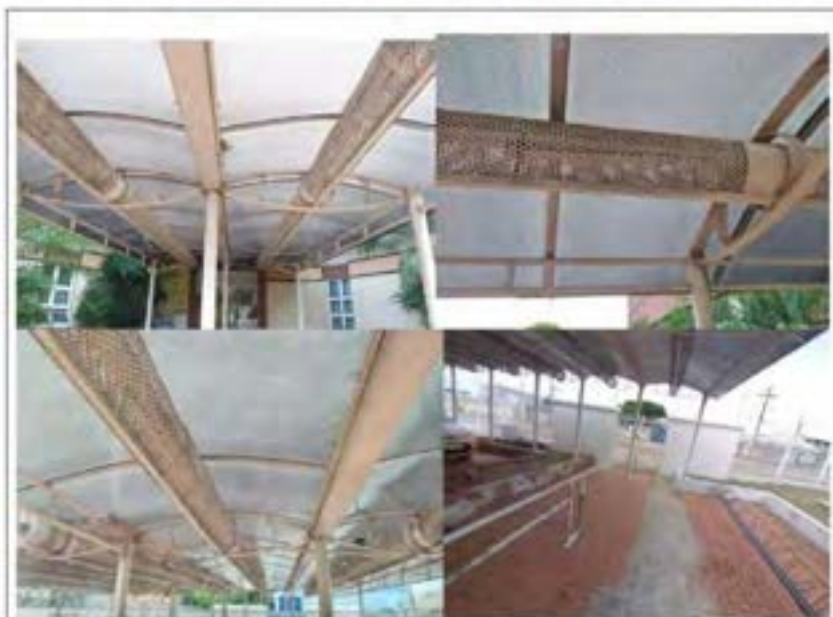
Fig 01. Entrada Principal – Cobertura de entrada em policarbonato;
