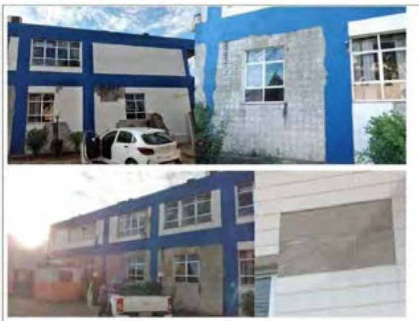
Fig 02. Fachada lateral esquerda.
