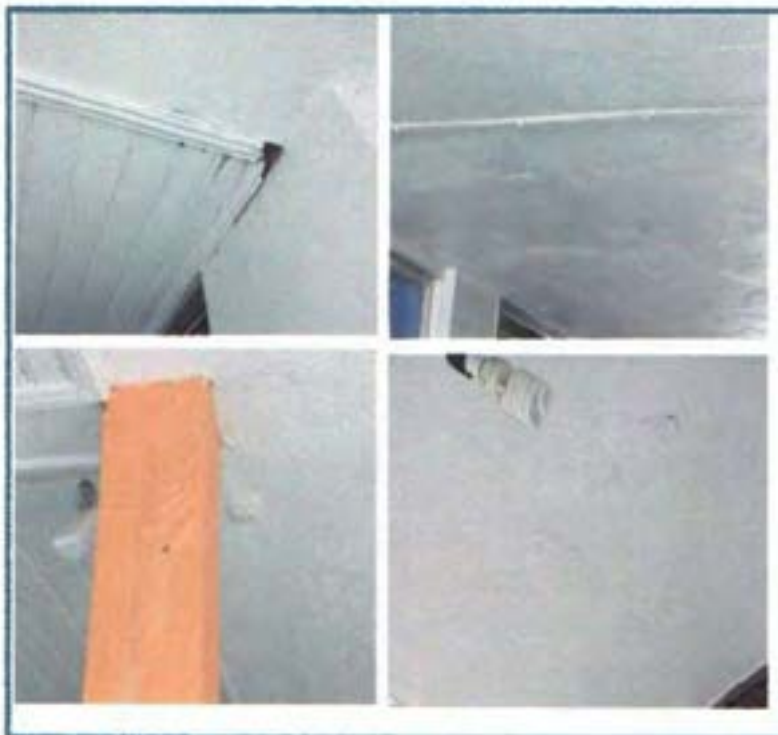
Fig 01. Corredor de Entrada – Forro e Cobertura;
