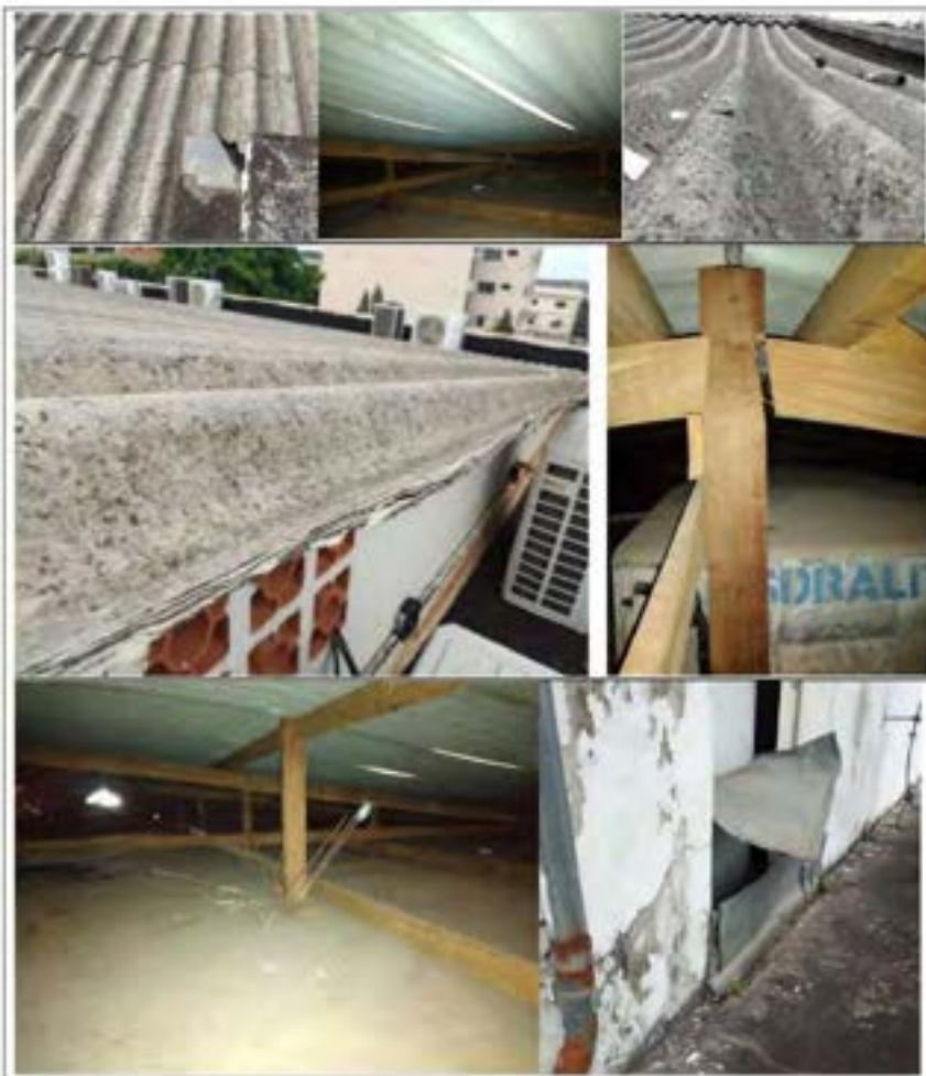
Fig 15. Cobertura em Fibrocimento e Estrutura de Madeira;
