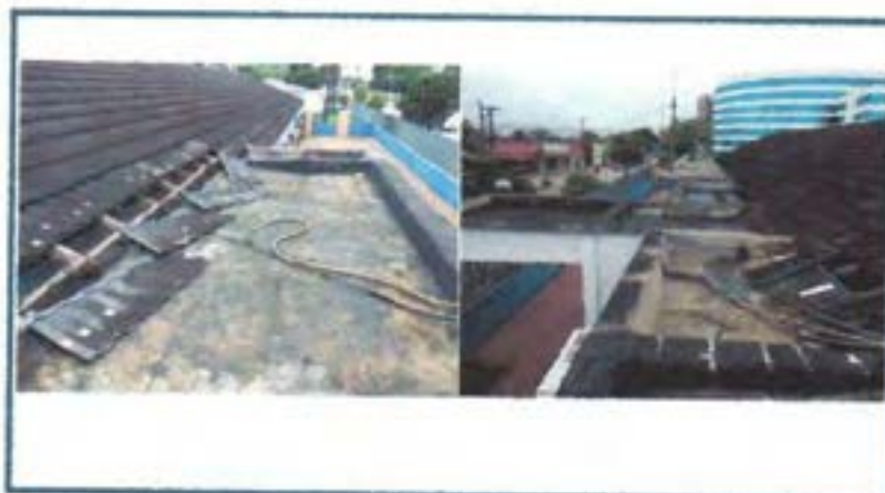
Fig 07. Cobertura em laje – Sala de estética e Marquise;
