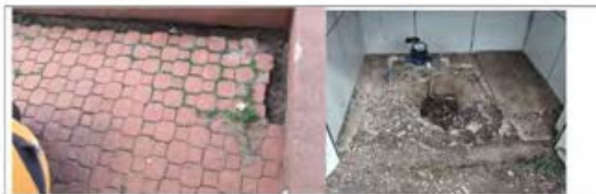
Fig 12. Reparo e pintura em piso intertravado e remanejamento de medidor de águas.
