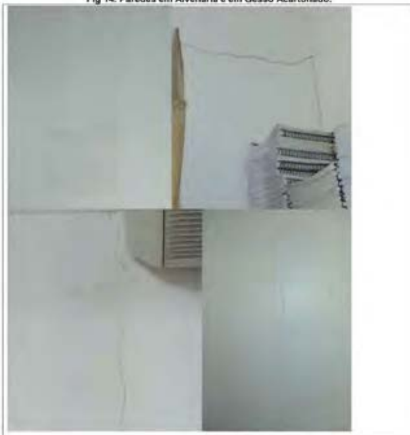
Fig 14. Paredes em Alvenaria e em Gesso Acartonado.
